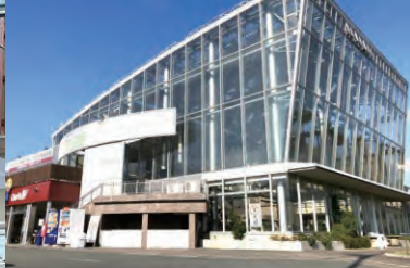
ガラス張りが目を引く建物は、太陽光を取り込み、館内はとても明るい。
