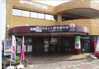
大牟田駅東口を出てすぐの建物。ジャーフの看板が目印です。
